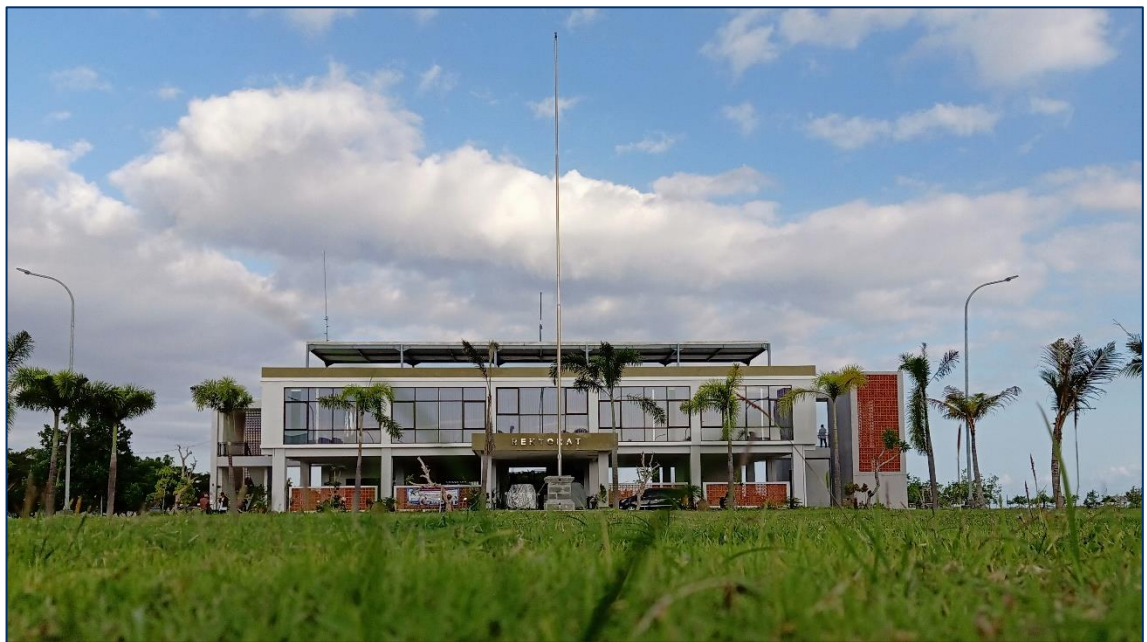
Gambar I.3. Gedung Rektorat Politeknik KP Jembrana.
