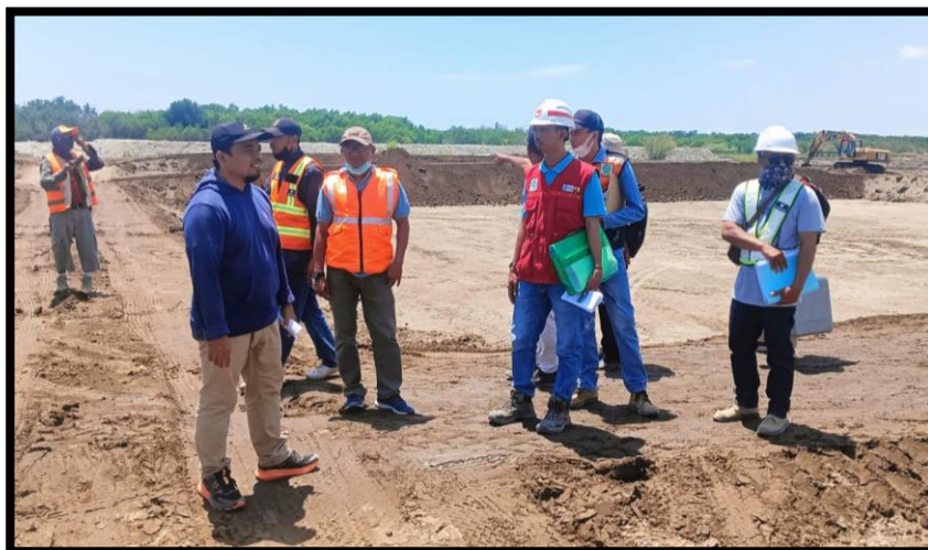
Gambar 11. Progres Pembangunan Kegiatan Klaster Tambak Udang
