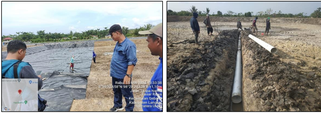
Gambar 7. Proses pemasangan pipa dan plastik HDPE
