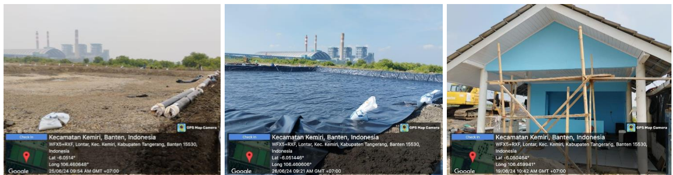
Gambar 10. Proses pemasangan HDPE dan rehab rumah jaga
