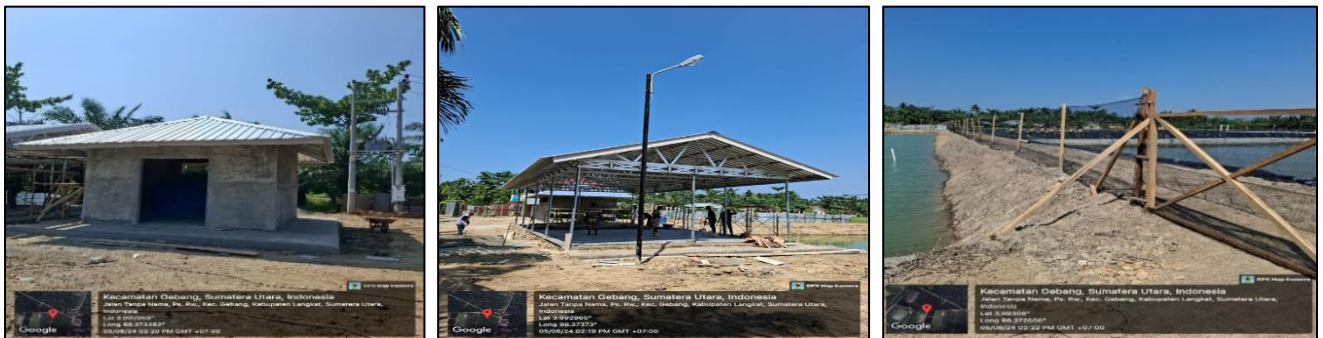
Gambar 9. Kontruksi bangunan pendukung (bangsal panen, ruang genset dan biosekuriti)
