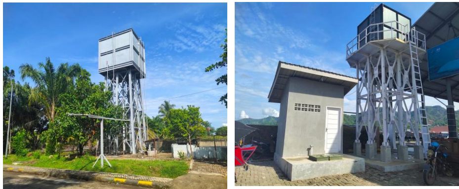
Gambar 5.10. Foto Instalasi Air Tawar
