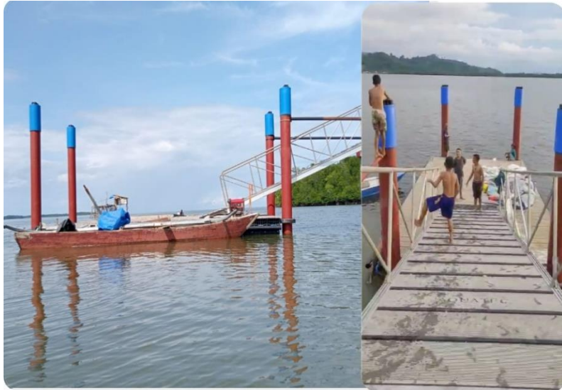
Gambar 17. Dermaga Apung Pulau Kambunong, Kab. Mamuju Tengah
