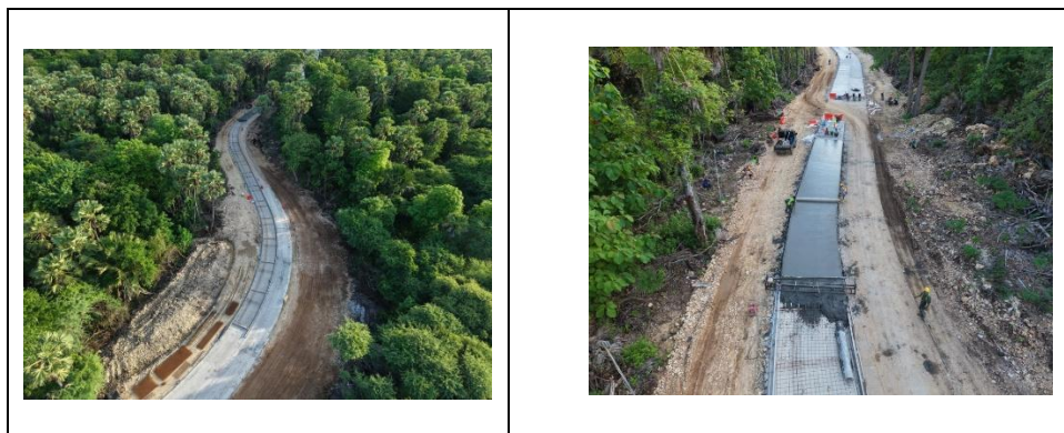
Gambar 8. Pekerjaan Timbunan Tanah, Pekerjaan LC Jalan Utama, Pekerjaan Bekisting dan Wiremesh, Pengecoran Rigid Beton
