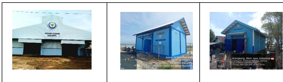
Gambar 11. Gudang Garam Nasional dan Gudang Garam Rakyat
