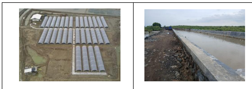
Gambar 12. Pekerjaan tunnel SWRO dan Long Storage di Kabupaten Cirebon
