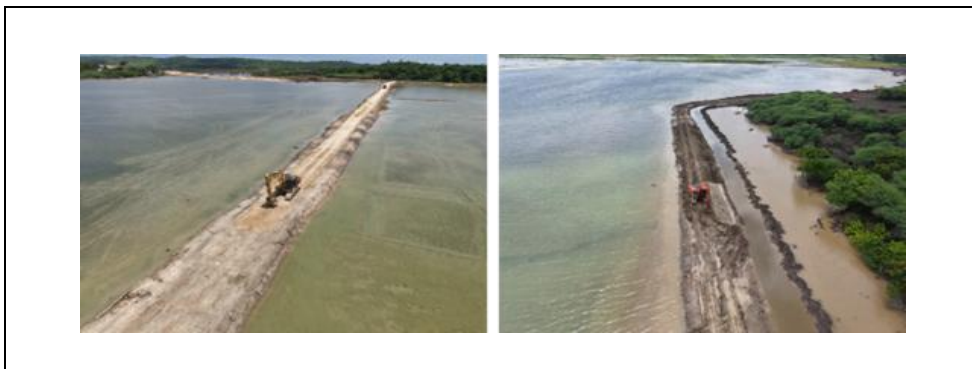
Gambar 7. Pekerjaan Galian dan Timbunan Kolam Peminihan Pond 2, Tanggul Luar Pond & Saluran Drainase Luar Pond dan Tanggul Batas Pond
