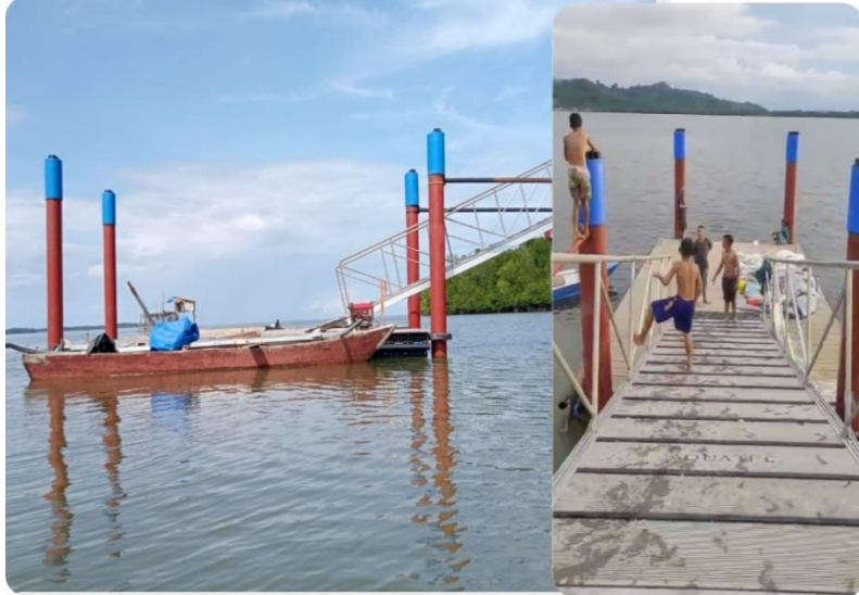
Gambar 17. Dermaga Apung Pulau Kambunong, Kab. Mamuju Tengah
