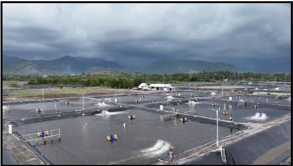
Gambar 11. Klaster Tambak Udang Yang Siap Operasional
