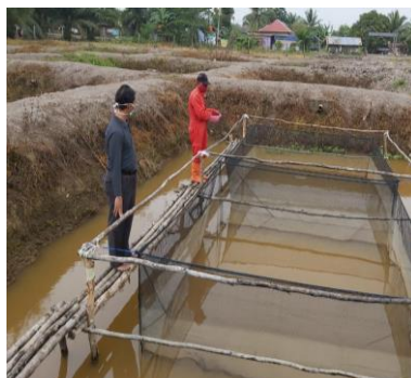
Proses pemasangan naungan pada kolam pendederan ikan gabus
