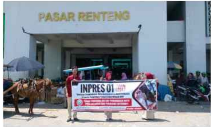
Foto bangunan depan Pasar Renteng, Praya – Kabupaten Lombok Tengah
