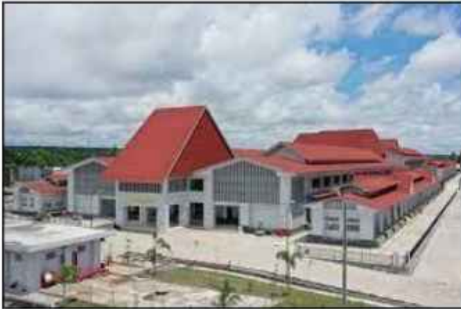
Foto bangunan Pasar Renteng tampak luar secara keseluruhan
