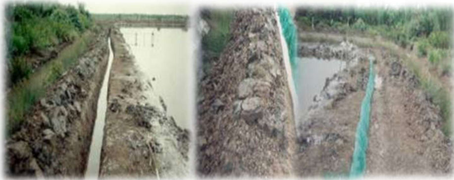
Gambar 2a. Teknik pemasangan lapisan inti waring pada pematang
