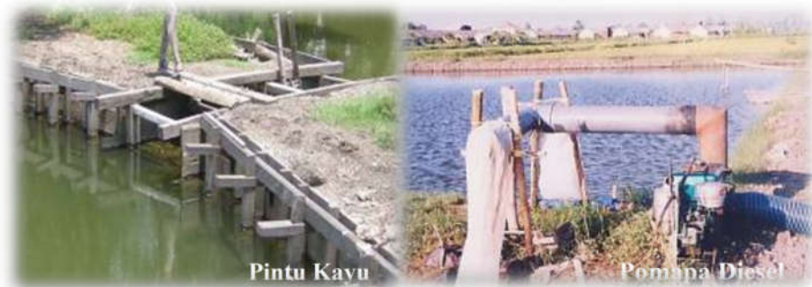
Gambar 3. Pemasukan air dengan pintu kayu dan atau pompa diesel dilengkapi saringan ukuran T-45 untuk mencegah udang/ikan liar
