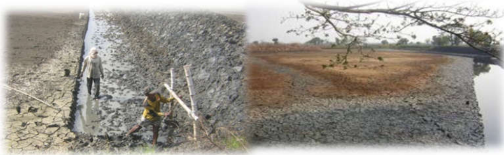
Gambar 6. Proses penataan caren dan pengeringan tanah dasar tambak
